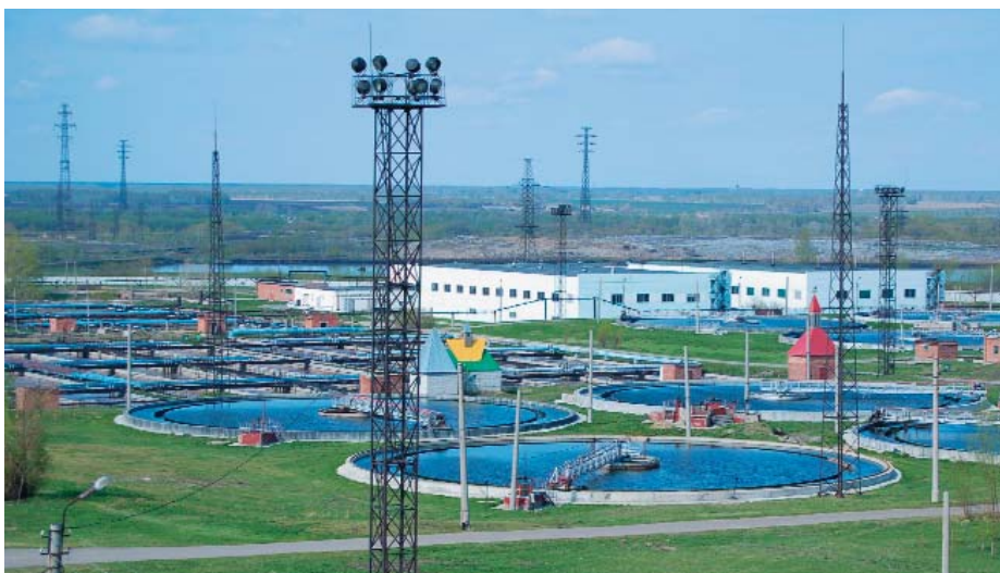
Панорама очистных сооружений канализации (Водоканал города Омск)
