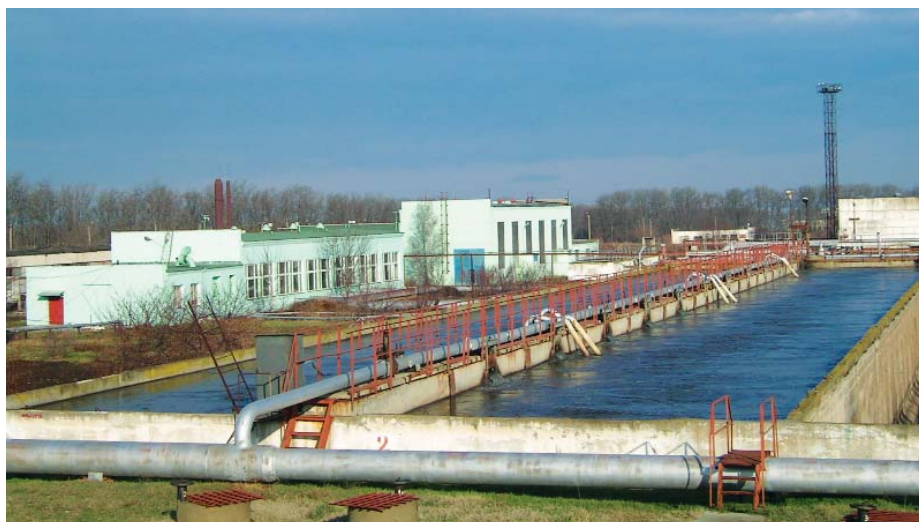
Очистные сооружения канализации с полной биологической очисткой мощностью 78 тыс м 3 в сутки (водоканал города Анапы)
