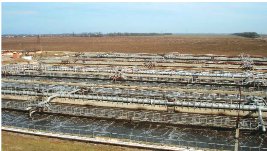
Очистные сооружения (водоканал города Барнаул)
