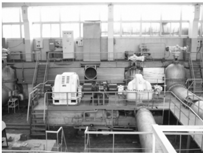
Рис. 1. Насосный агрегат, оборудованный регулируемым приводом UCD
