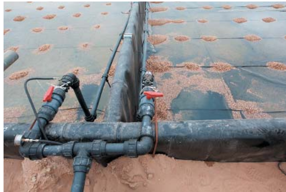
Рис. 6. Этапы строительства горизонтального ФОС с подповерхностным потоком и принудительной аэрацией
