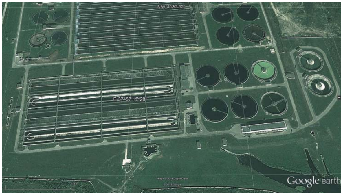
Рис. 6. Вид на блок УБЗ и сооружения ОБЕЗЗАРАЖИВАНИЯ НЛОС в период пуско-наладочных работ
