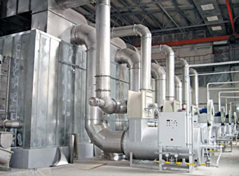
Сооружения термической сушки осадка, Уфа
