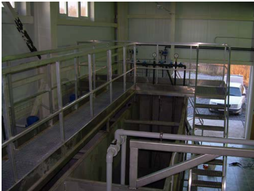
Рис. 4. Очистные сооружения в Белгородской обл.
