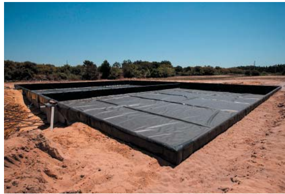
Рис. 6. Этапы строительства горизонтального ФОС с подповерхностным потоком и принудительной аэрацией
