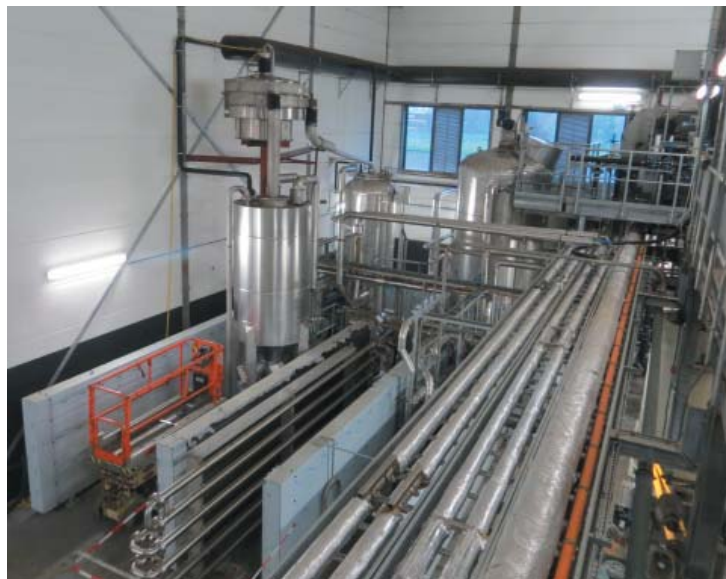
Рис. 2. ТЕРМООБРАБОТКА ОСАДКА СТОЧНЫХ ВОД. КОС, VENLO (НИДЕРЛАНДЫ)
