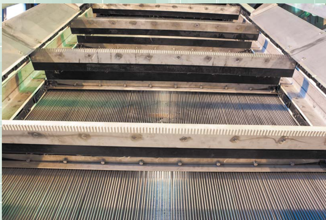
Рис. 2. Фильтровальное полотно решетки РС
