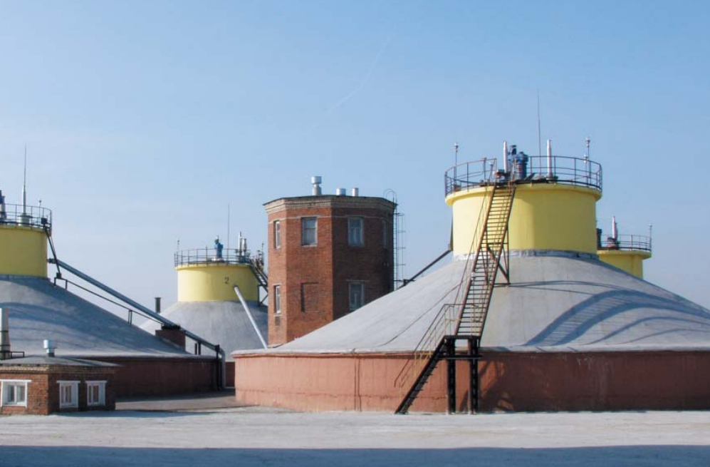
Реконструированные метантенки Люберецких очистных сооружений, Москва
