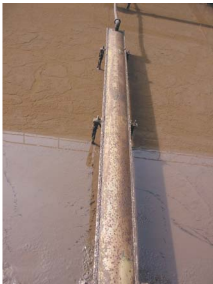
Рис. 17. ПРОЕКТНАЯ АЭРАЦИОННАЯ СИСТЕМА. НА РИСУНКЕ ВНИЗУ – ДЕФОРМАЦИЯ МЕМБРАНЫ
