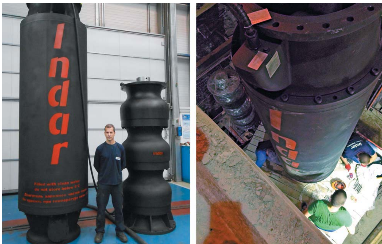
Рис. 1. Монтаж высоковольтных погружных насосов Indar выполнялся на станции 1-го подъема Западной станции водоподготовки агрегатированием электродвигателя и многоступенчатой улитки
