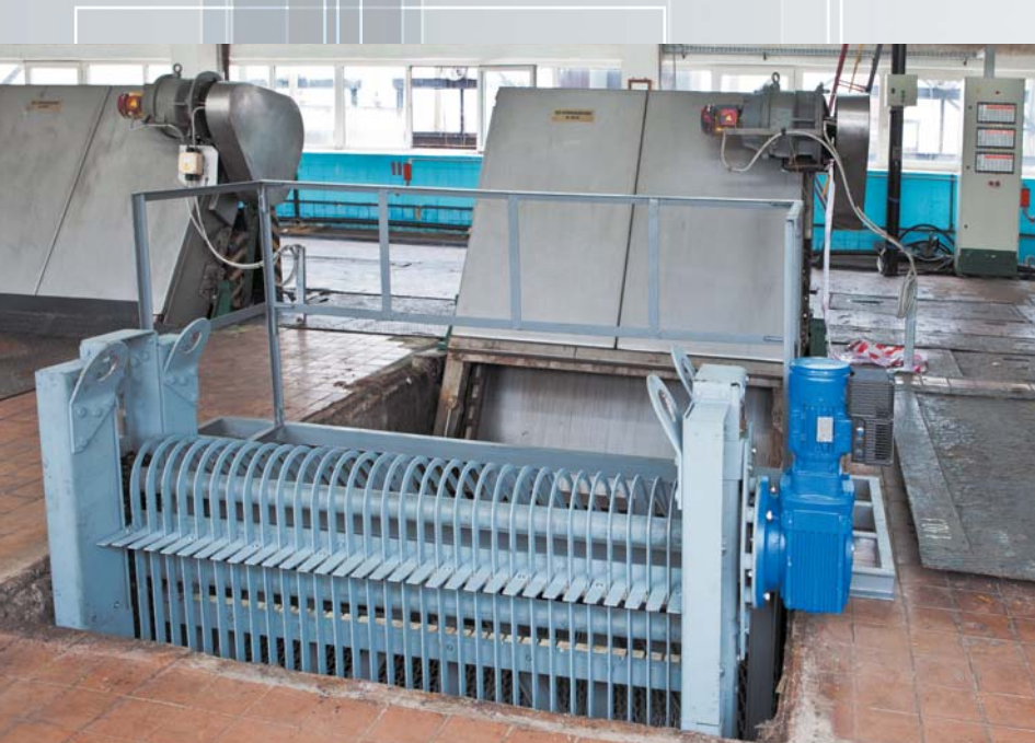
Рис. 3. Решетка модели РВ, установленная в одном канале с решеткой РС для обеспечения двухступенчатой очистки
