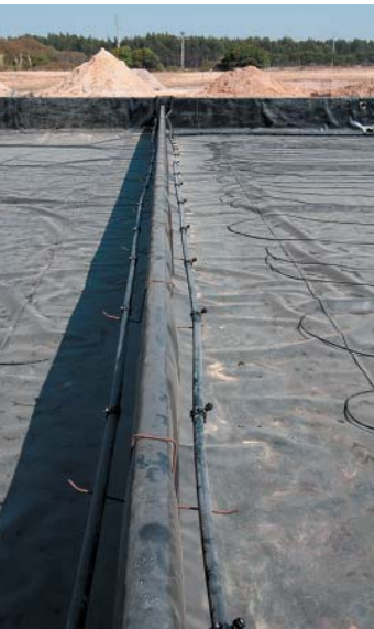
Рис. 6. Этапы строительства горизонтального ФОС с подповерхностным потоком и принудительной аэрацией
