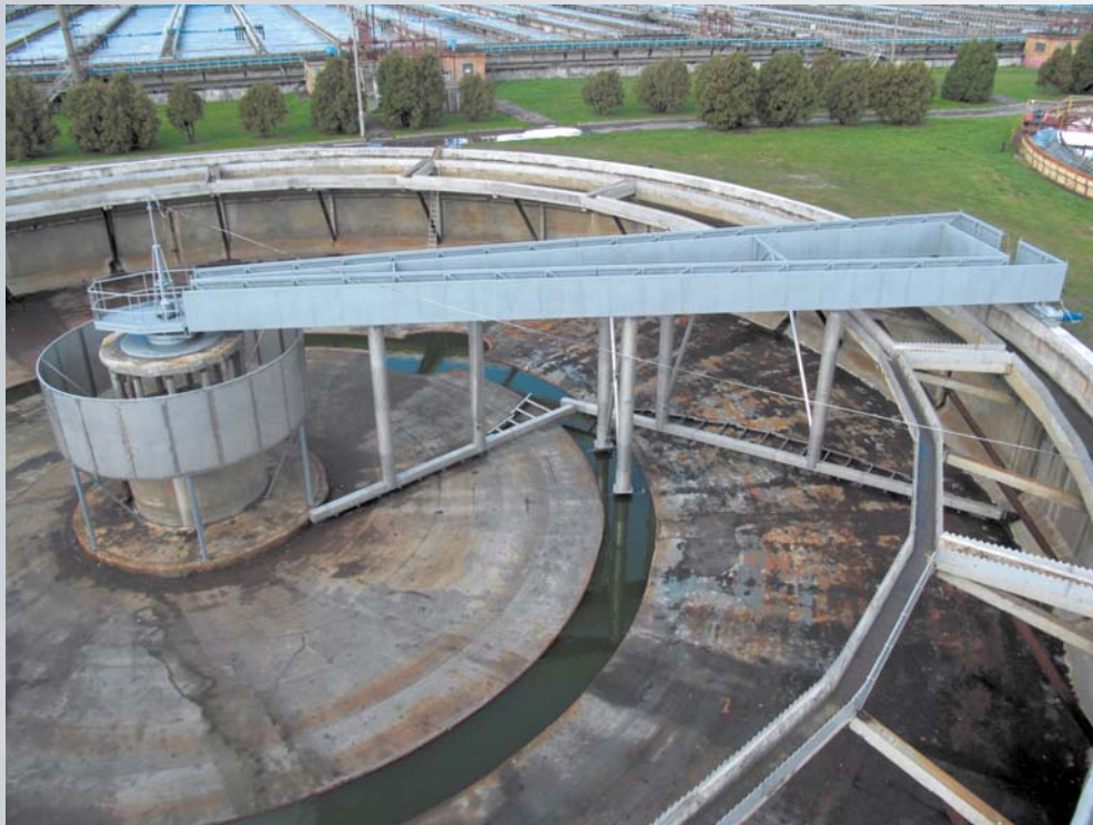
Рис. 5. Илоскреб марки ИЛ. КУРЬЯНОВСКИЕ ОЧИСТНЫЕ СООРУЖЕНИЯ
