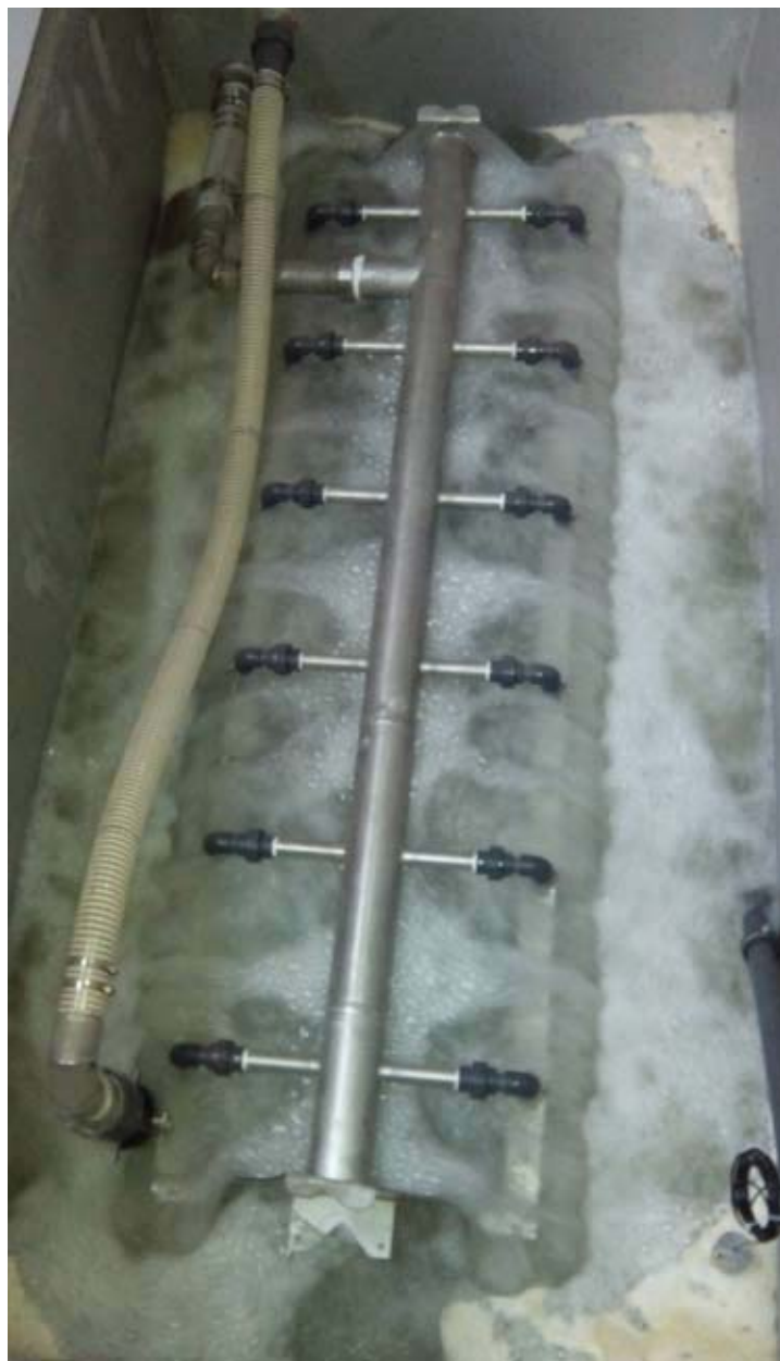
Рис. 5. Очистные сооружения в Белгородской обл.
