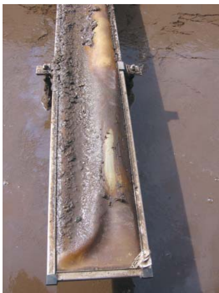
Рис. 17. ПРОЕКТНАЯ АЭРАЦИОННАЯ СИСТЕМА. НА РИСУНКЕ ВНИЗУ – ДЕФОРМАЦИЯ МЕМБРАНЫ
