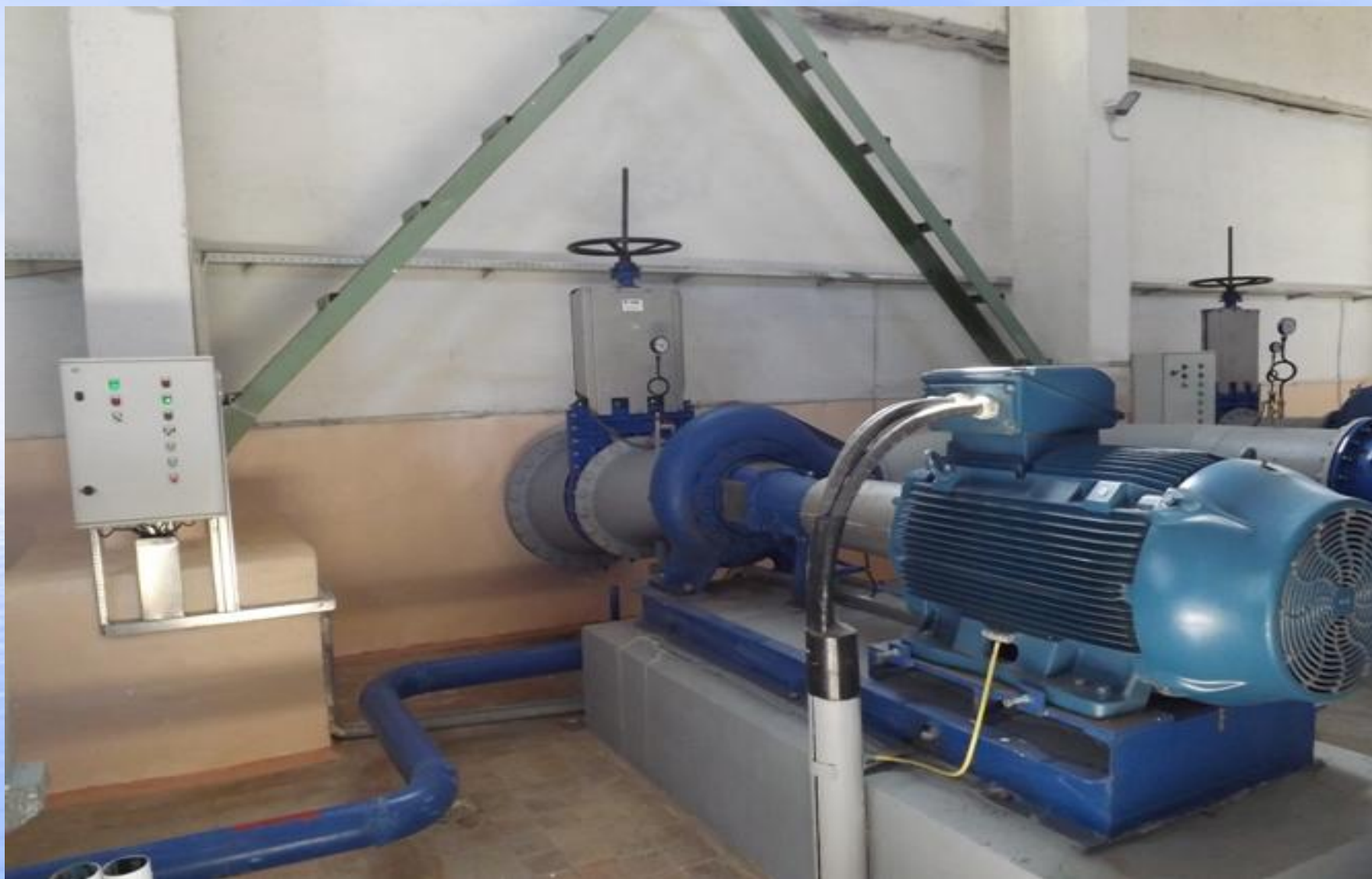
Насосное оборудование
