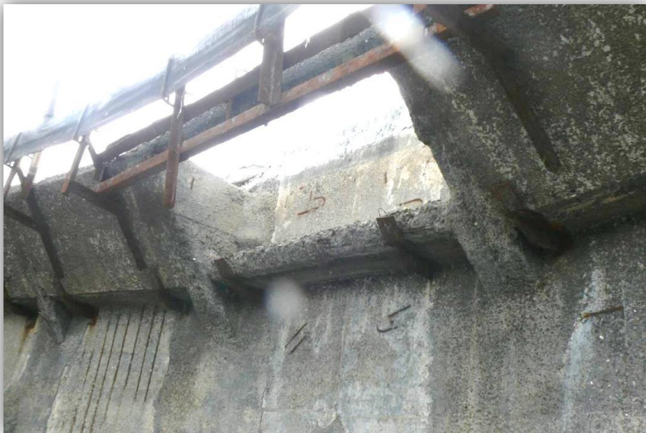
Сквозное отверстие в лотковом блоке, выполненное с нарушением рабочего армирования, без элементов усиления
