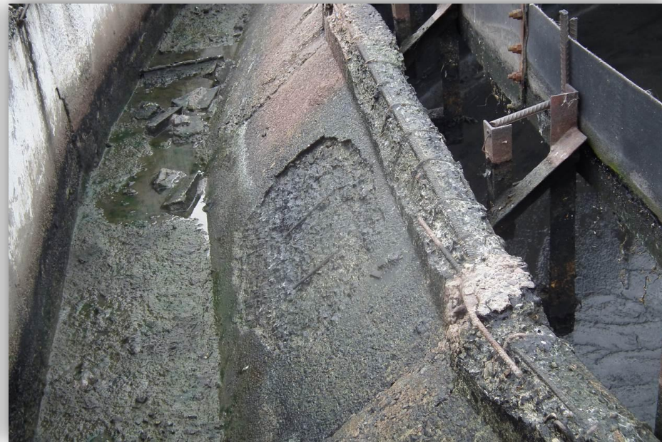
Разрушение бетона лоткового блока в зоне ребра и стенки, оголение рабочих арматурных стержней
