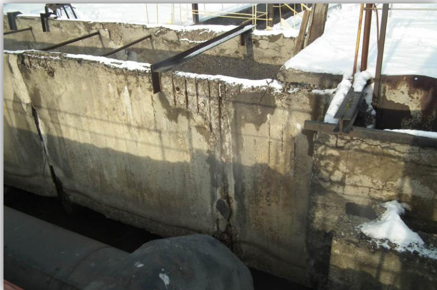
Фрагмент стеновых панелей распределительного канала (обширное разрушение бетона с оголением фрагментов рабочих арматурных сеток)
