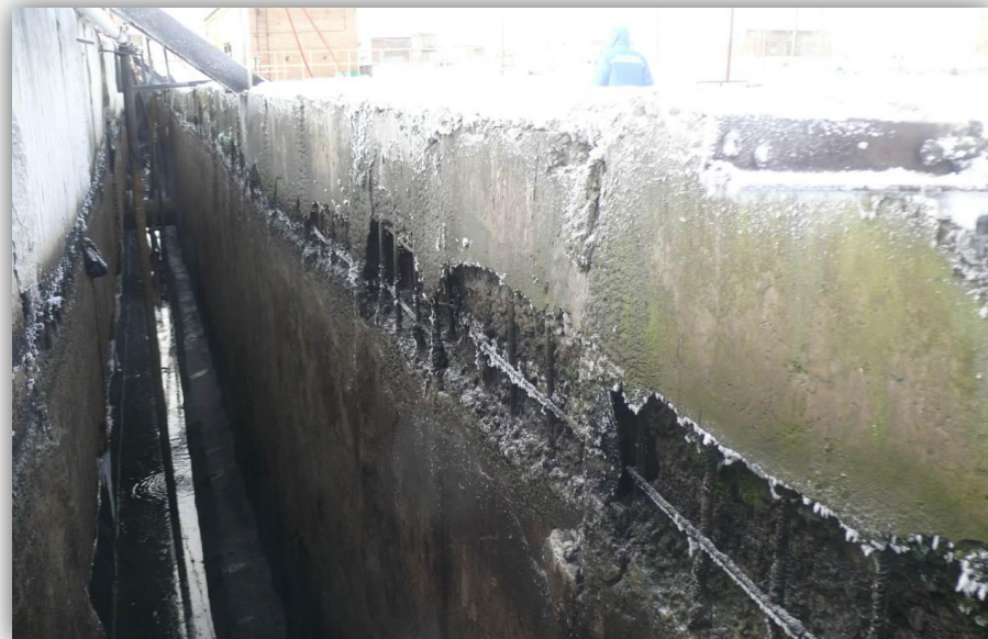
Общий вид внутренней поверхности стены распределительного канала (разрушение бетона панелей стен в границах колебания уровня рабочей жидкости с оголением фрагментов рабочих арматурных сеток)
