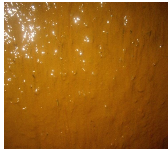
Покрытие «Монолит – Аква», нанесённое в камере
