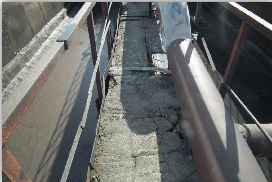
Сквозное разрушение полки плиты ходового мостика
