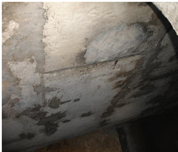
Поверхность стен камер перед нанесением покрытия
