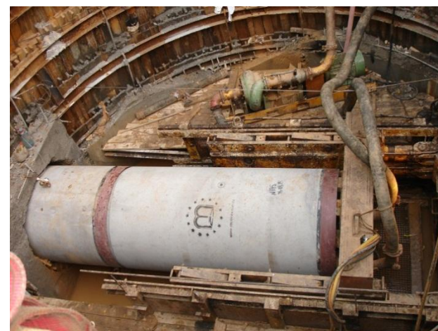
Строительный котлован для производства работ с помощью микрощита
