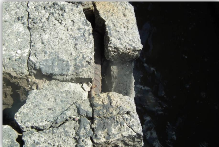
Разрыв соединительной арматуры в узле крепления стеновых панелей между собой
